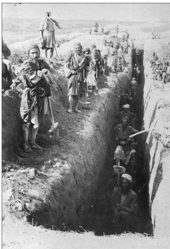
▼ Les ouvriers creusant des tranchées à Suse
